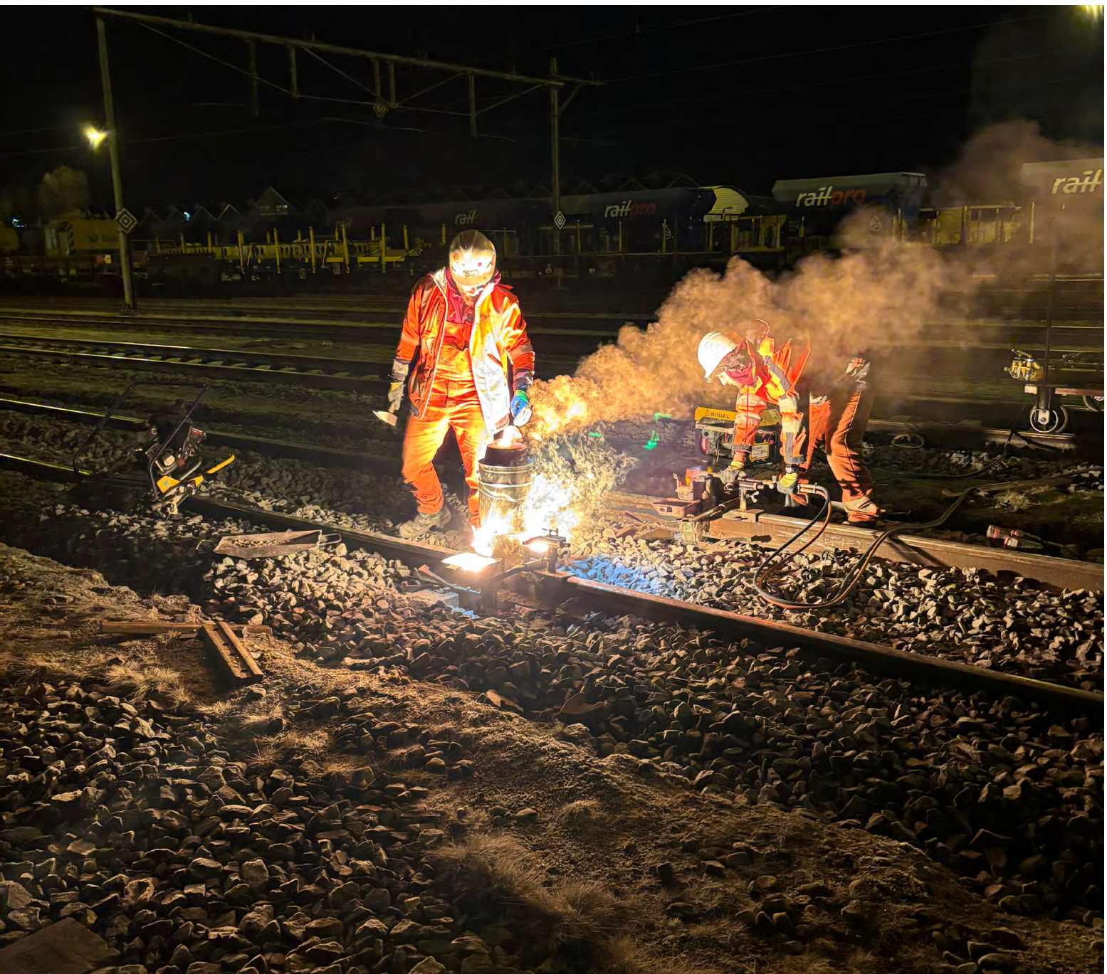
Nachtwerk aan het spoor. Foto: Nederlandse Arbeidsinspectie
