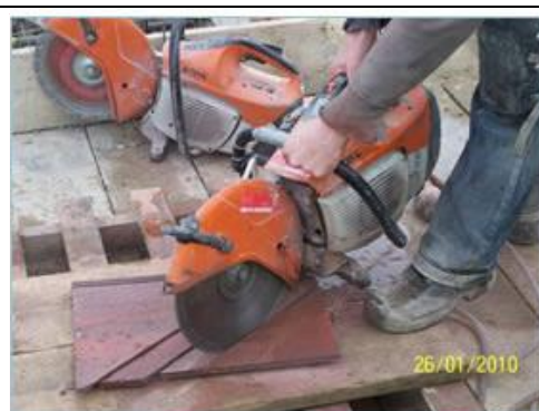
Goede praktijk – Dakpannen doorknippen met een dakpanknipper (National Federation of Roofing Contractors Ltd., GB)
