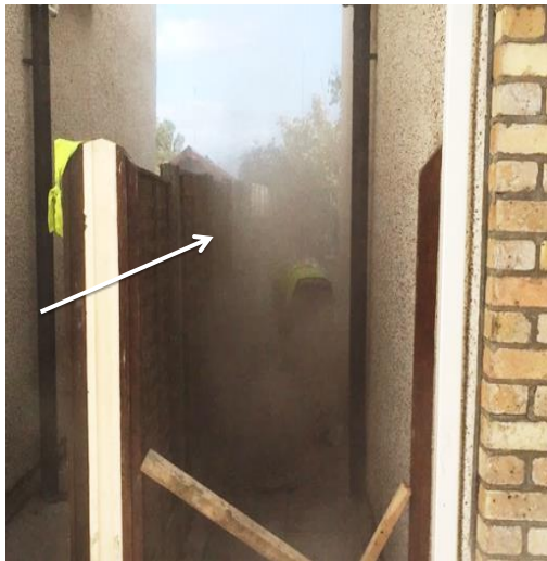
Figuur 1: Hoge blootstelling aan RCS-stof De pijl wijst naar de werknemer (Bron HSA, IE)
