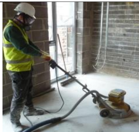
Goede praktijk – polijsten van betonvloer met afzuiging op het gereedschap (HSE, GB)
