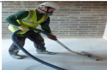
Goede praktijk – Stofopruiming met een stofzuiger voorzien van een HEPA-filter (HSE, GB)
