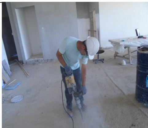
Slechte praktijk – Werken met een breekhamer zonder afzuiging op het gereedschap (DLI, CY)
