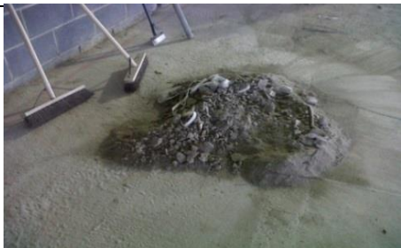
Slechte praktijk – Droog opruimen van puin met een borstel (HSE, GB)
