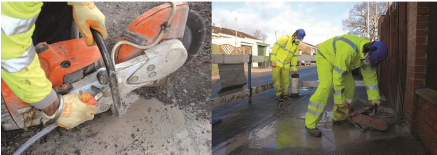
Figuur 2 foto's van het stofbestrijdingssysteem met water: (bron HSE, GB)
