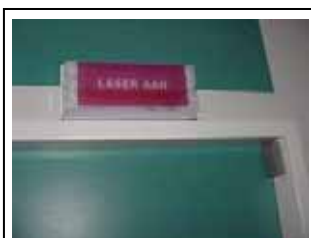
Fig. 45c Lichtbak met signalering "laser aan" bij de toegang tot een laseropstelling.
